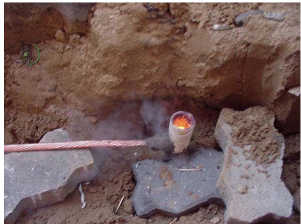
รูปที่ 5-8 การเชื่อมต่อหลักดินกับสายต่อหลักดินด้วยวิธีเชื่อมด้วยความร้อน
